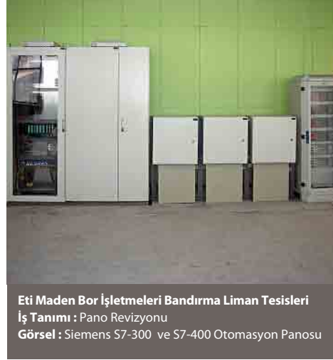
Eti Maden Bor İşletmeleri Bandırma Liman Tesisi İş Tanımı : Pano Revizyonu Görsel : A.G. Panosu
