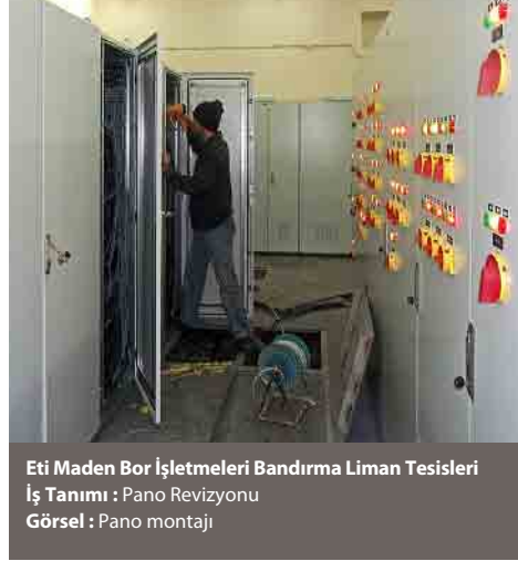
Eti Maden Bor İşletmeleri Bandırma Liman Tesisi İş Tanımı : Pano Revizyonu Görsel : Siemens S7-300 ve S7-400 Otomasyon Panosu
