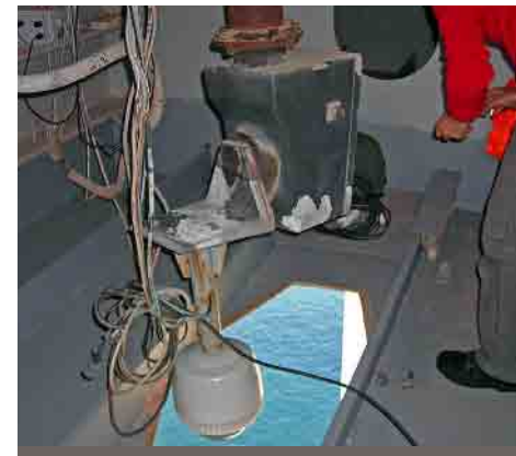
K.G.M. Boğaziçi Köprüsü İş Tanımı : Kamera Güvenlik Sistemi Kurulumu Görsel : Köprü Ayağındaki Dome Kamera Kurulumu
