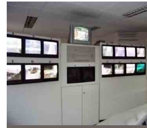
K.G.M. F.S.M. Köprüsü İş Tanımı : Kamera Güvenlik Sistemi Kurulumu Görsel : Köprü Kamera Kontrol Odası
