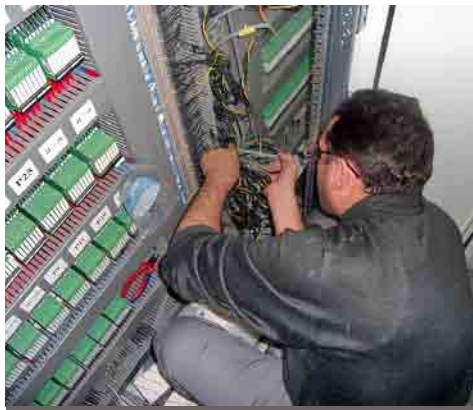
Eti Maden Bor İşletmeleri Bandırma Liman Tesisi İş Tanımı : Pano Revizyonu Görsel : Siemens PLC Otomasyon Panosu Montajı
